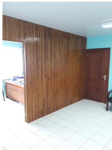
Composant : Parois Cloison intérieur (N) Lame Bois – Bâtiment 2 (pièce 16)
