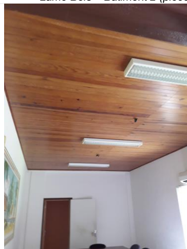
Composant : Faux plafond (N) Lame de bois – Bâtiment 2 – Salle de réunion 2 (pièce 10)
