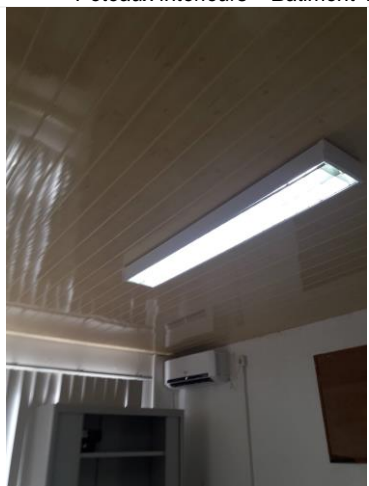
Composant : Faux plafond (N) Lambris PVC type 1 – Bâtiment 2 (pièces 1, 2,3)
